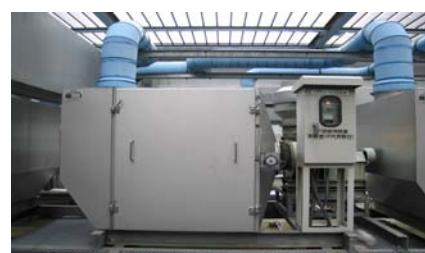
有機溶剤用脱臭装置
