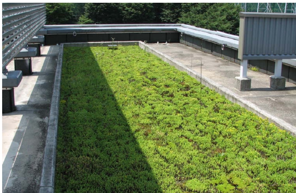
小平庁舎の屋上緑化
