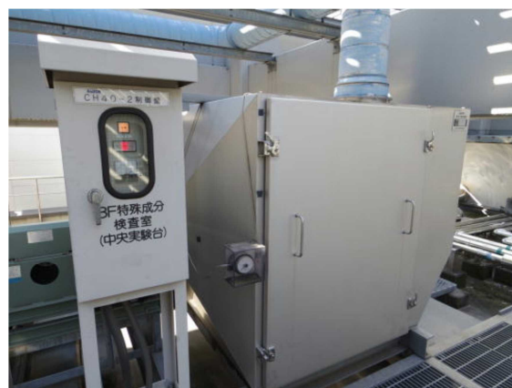
活性炭式脱臭装置(乾式スクラバー)
