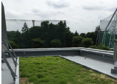
小平庁舎屋上①
