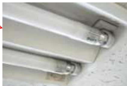
LED照明の設置(札幌)
